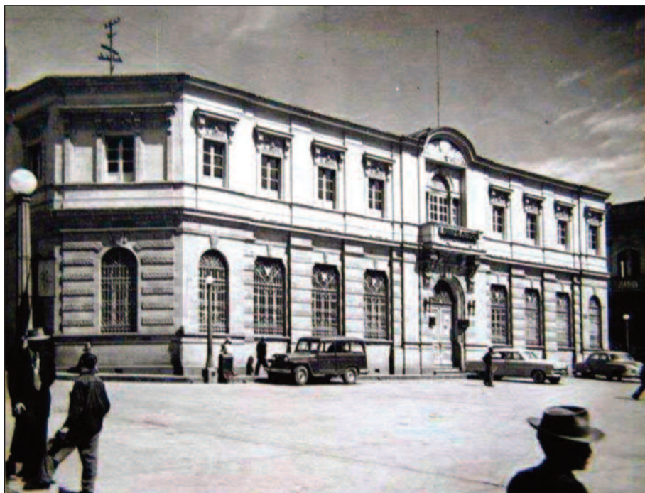
Quetzaltenango, l'edificio del Banco de Occidente, foto d'epoca
